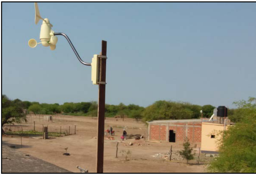
Instalación de Veleta y Anemómetro
