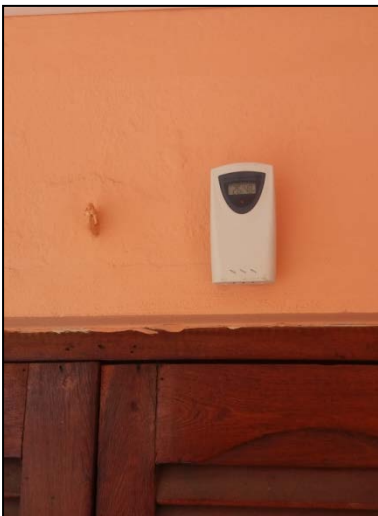
Instalación de Termohigrosensor
